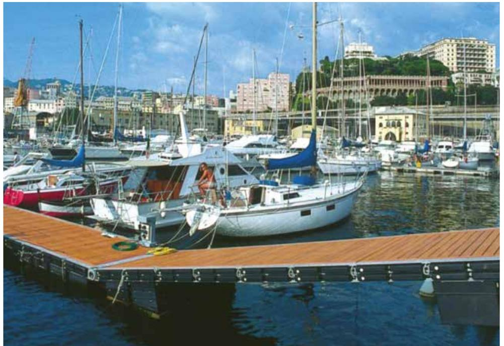
La passerella autoportante Martini Marinas ha la stessa larghezza del pontile. Il risultato è un camminamento continuo con un piano di calpestio senza gradini e senza barriere architettoniche.
