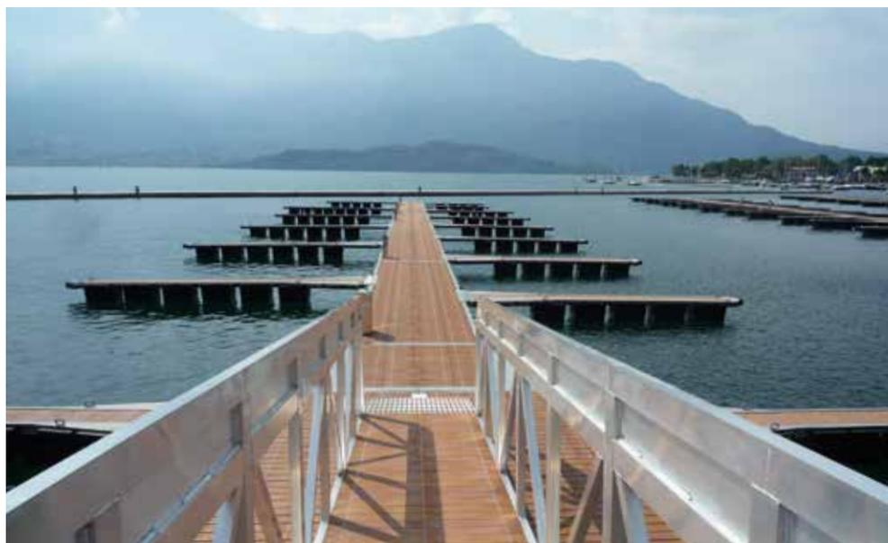
Il finger, fissato al pontile tramite cerniere, è pedonabile ed è studiato per consentire l'attracco, l'ormeggio e l'accesso a bordo delle imbarcazioni. Il minifinger, non pedonabile, facilita le operazioni di ormeggio ed attracco. In particolare viene utilizzato per suddividere i posti barca.
