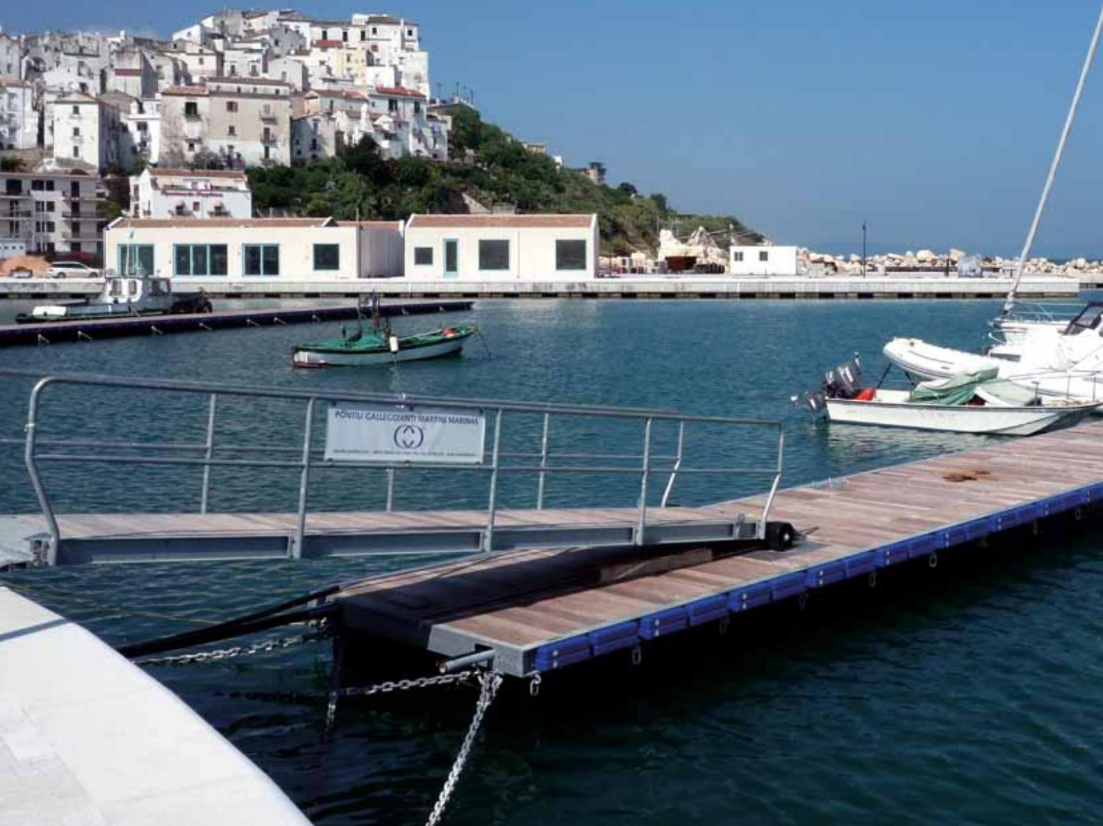
La passerella autoportante Martini Marinas ha la stessa larghezza del pontile. Il risultato è un camminamento continuo con un piano di calpestio senza gradini e senza barriere architettoniche.
