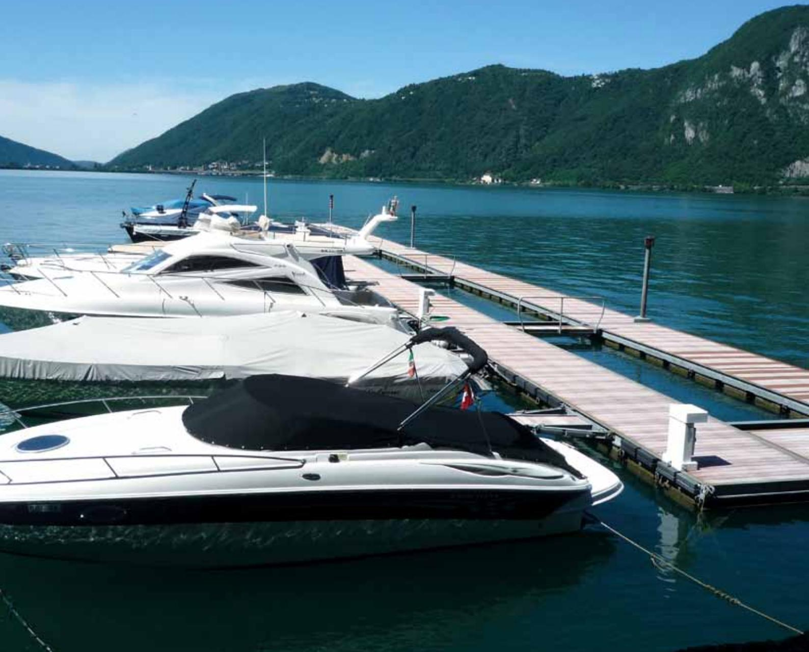
Il frangiflutti galleggiante Martini Marinas, con speciale sistema a volumi differenziati, è frutto di attente sperimentazioni idrauliche. La sua struttura a catamarano contrasta il moto ondoso dissipandone efficacemente l'energia.
