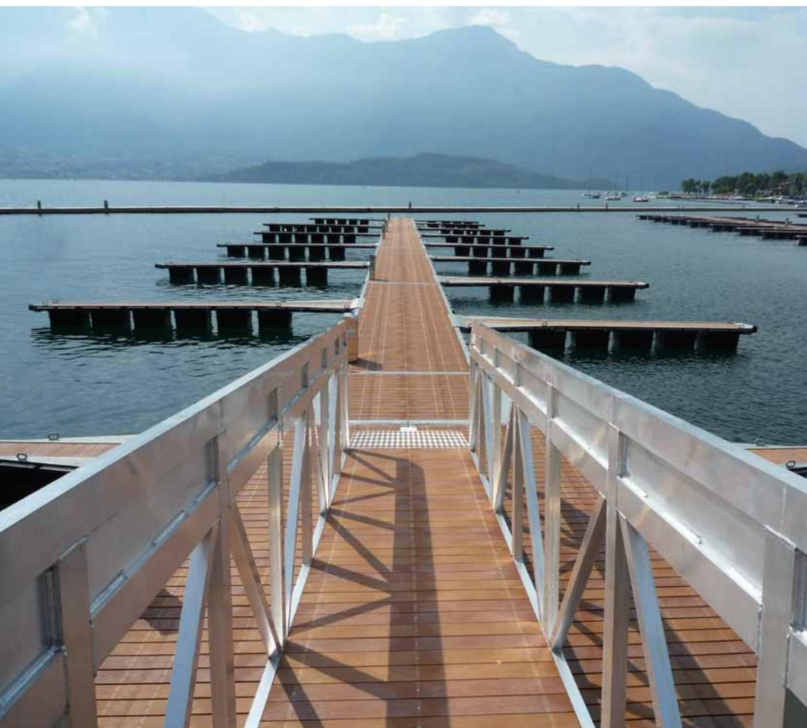
Il finger, fissato al pontile tramite cerniere, è pedonabile ed è studiato per consentire l'attracco, l'ormeggio e l'accesso a bordo delle imbarcazioni. Il minifinger, non pedonabile, facilita le operazioni di ormeggio ed attracco. In particolare viene utilizzato per suddividere i posti barca.
